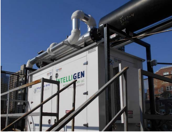
Intelligen 250 kW CHP unit.
